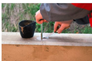
Ihned po ukotvení, očistit okolí vývrtnu od přebytečné hmoty.
