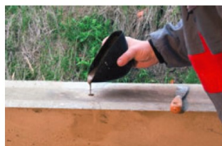
Vývrt vyplnit cca z 1/3 kotvicím cementem.
