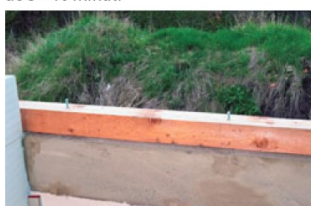
Po vytvrdnutí PUR STONE uložit pozdnici.
