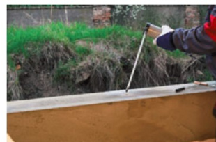
...pomocí pumpičky vyfoukat prach z vývrtnů...
