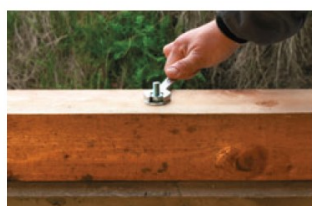
Nasadit podložku a utáhnout matici...
