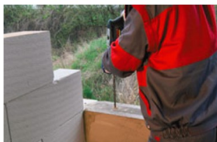
Vyvrtat otvory pro ukotvení pozdnice do požadované hloubky.
