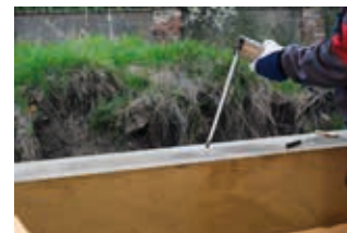
...pomocí pumpičky vyfoukat prach z vývrvtů...
