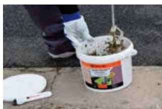
Rozmíchat nejprve potřebné množství CEMENT ADDITIVE s vodou.
