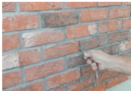
Pro styčné spáry volte kratší spárovací lžíci.
