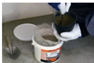
Rozmíchat potřebné množství PUR STONE dle návodu. Rozmíchat vždy jen takové množství, které stihnete zpracovat do 5–10 minut.
