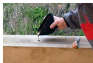
Vývrvt vyplnit cca z 1/3 kotvicím cementem.
