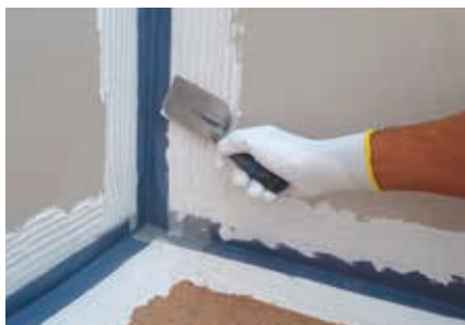
4. Vložit těsnící pás do čerstvého nátěru.
