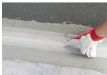
4. Izolace exponovaných míst: Vložit Těsnící pásy, vnější rohy a vnitřní kouty.
