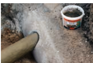
Do vysekaného průrazu v horní třetině nasounout přípojnou potrubí.
