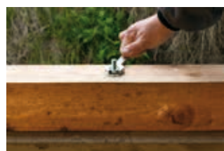
Nasadit podložku a utáhnout matici...
