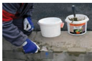
Pomocí rohové lžice odstranit přebytečnou hmotu a vytvarovat vnější hranu betonové zídky.
