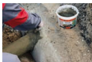
Z rozmíchané hmoty WATER STOP si vymodelovat „válečky“ a vytvořit prsteneč kolem napojení.
