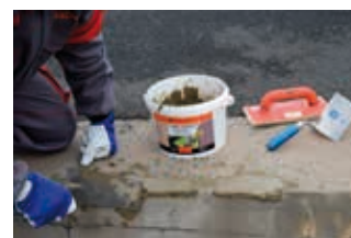
Nanést na podklad pomocí zednické lžice potřebné množství hmoty.
