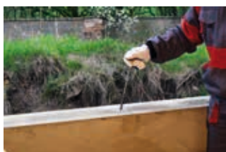
...a odstranit uvolněné částice pomocí kartáčku.
