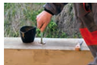
Do vývrvtu ihned zasunout šroubovým pohybem závitovou tyč nebo jiný kotvicí prvek.
