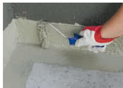
3. Izolace exponovaných míst: Nanést nátěr do koutů a vytáhnout jej cca 15 – 20 cm od lomu nebo dilatační spáry na každou stranu.
