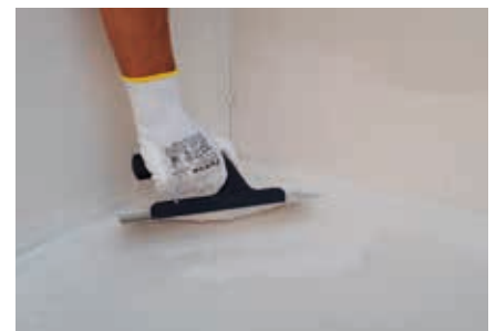
6. Po zaschnutí prvního nátěru nanést celoplošně druhou vrstvu nátěru.
