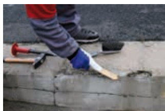
Pomocí ocelového kartáče odstranit uvolněné části.
