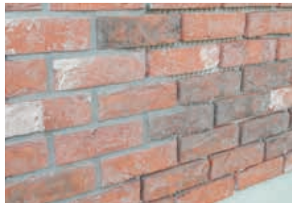
Zdivo s raženým obkladovým páskem.
