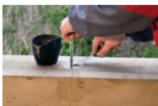
Ihned po ukotvení, očistit okolí vývrvtu od přebytečné hmoty.
