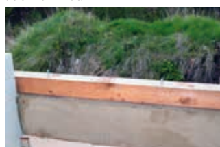
Po vytvrnutí PUR STONE uložit pozednici.
