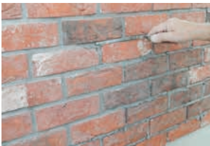
Upravte ložné spáry do požadovaného tvaru.
